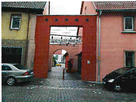
Bild: Haus Gylnheim in der Hauptstraße (Quelle: WSW & Partner)
