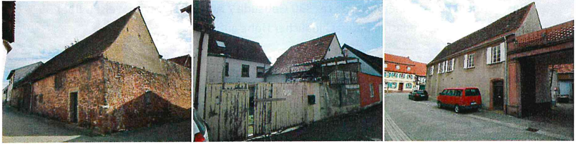
Bilder: Gebäude mit Sanierungsbedarf (Quelle: WSW & Partner)
