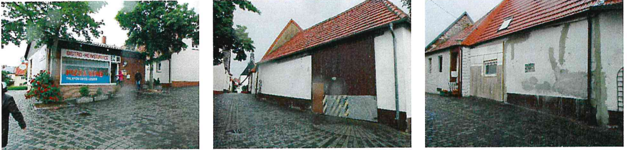
Bilder: Sanierungsbedürftige Bebauung im Bereich Hintergasse / Freiherr-von-Stein-Straße (Quelle: WSW & Partner)
