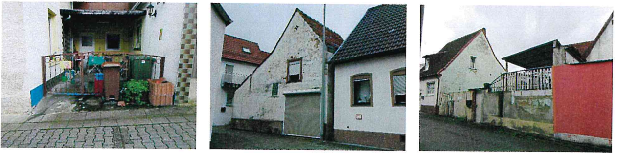
Bilder: Gebäude mit (erheblichem) Sanierungsbedarf (Quelle: WSW & Partner)
