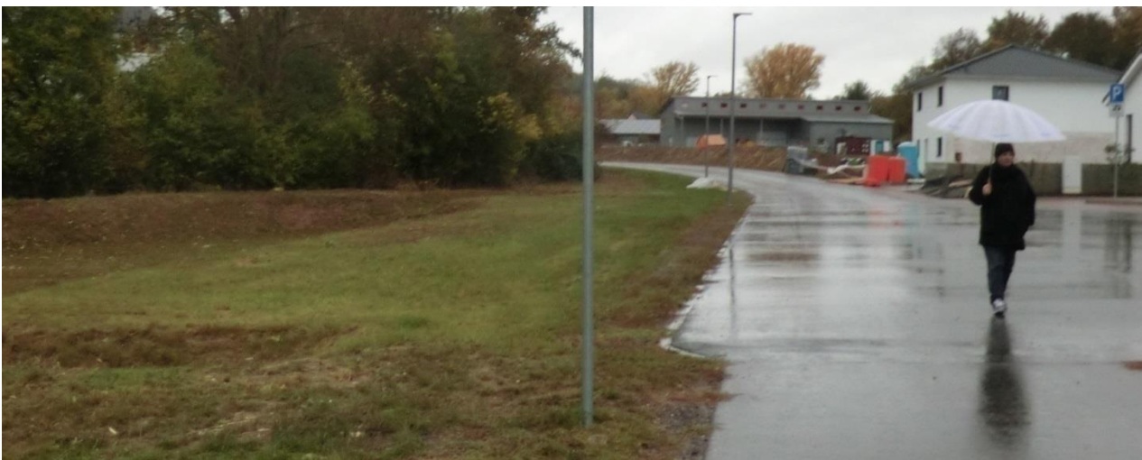
Abbildung 37: Rückhaltebecken am Leiselsbach, Albisheim
