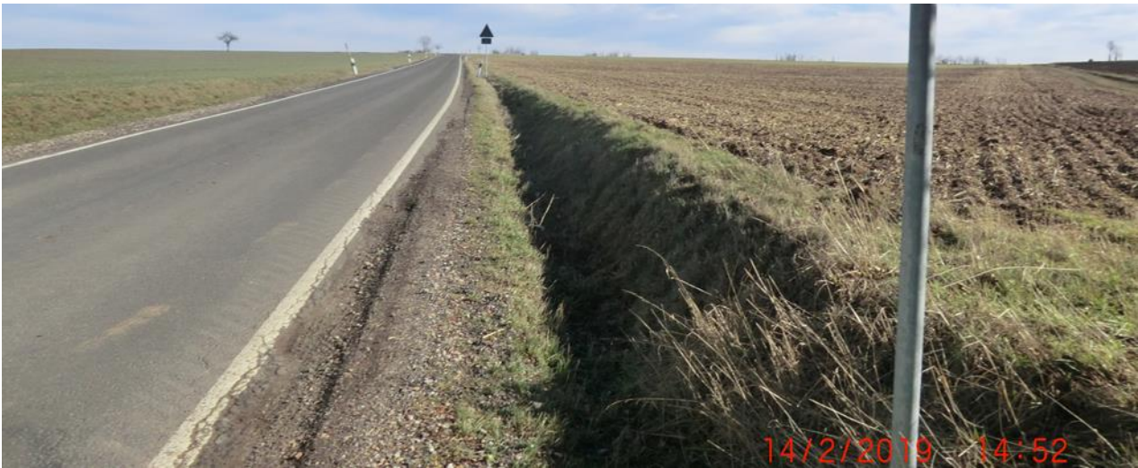
Abbildung 46: Seitengraben entlang Landesstraße
