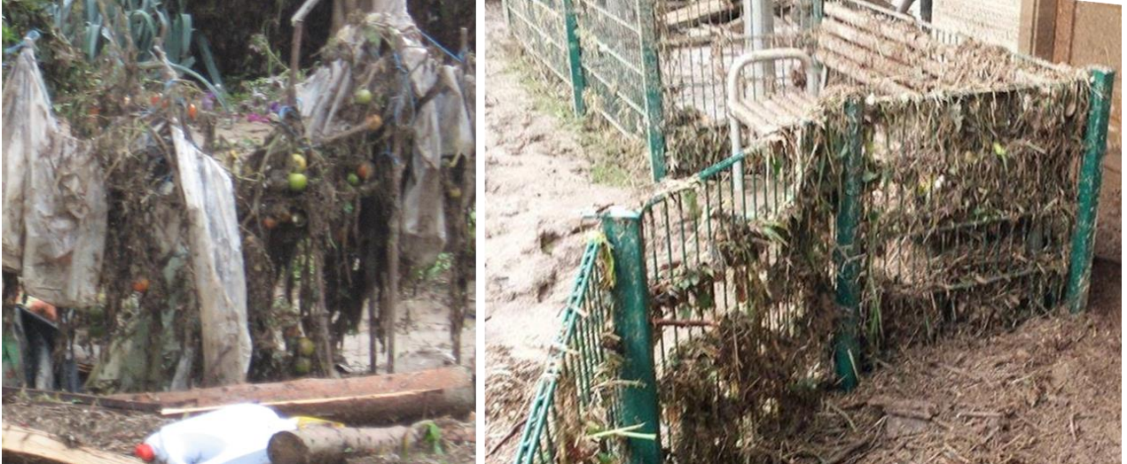
Abbildung 84: Abflusshindernisse durch Treibgut
