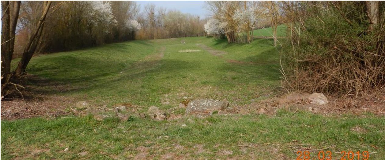
Abbildung 41: Rückhaltebecken Lochbach, Göllheim
