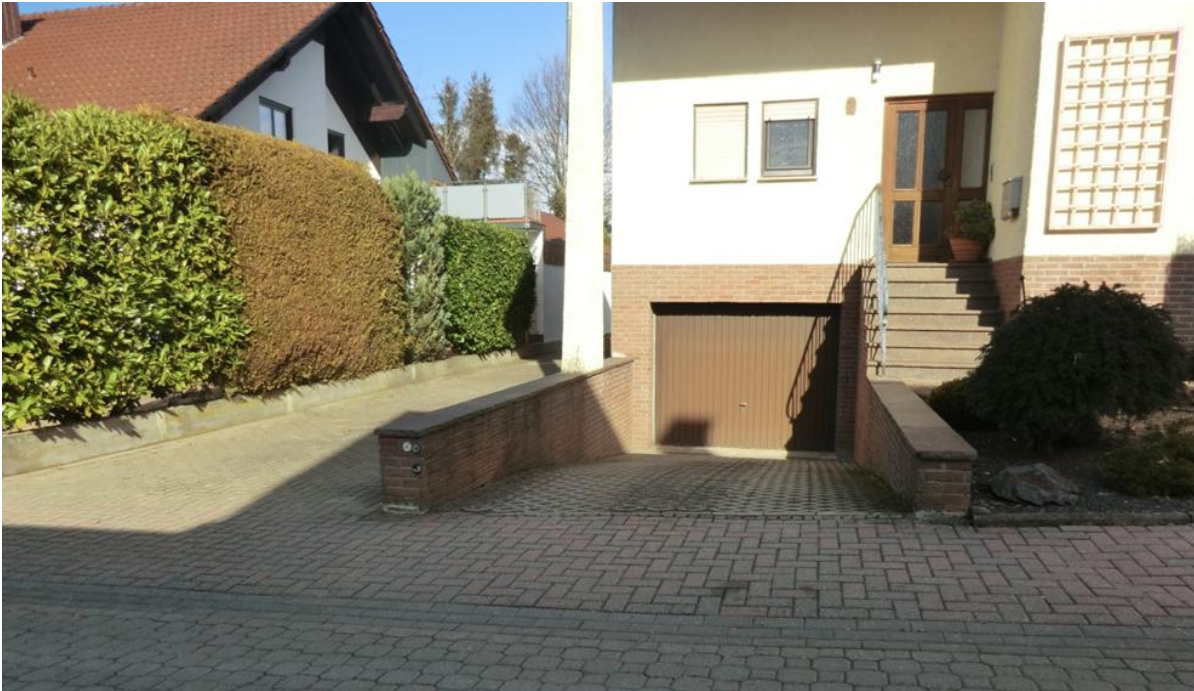
Abbildung 66: Tiefliegende Gebäudeöffnungen
