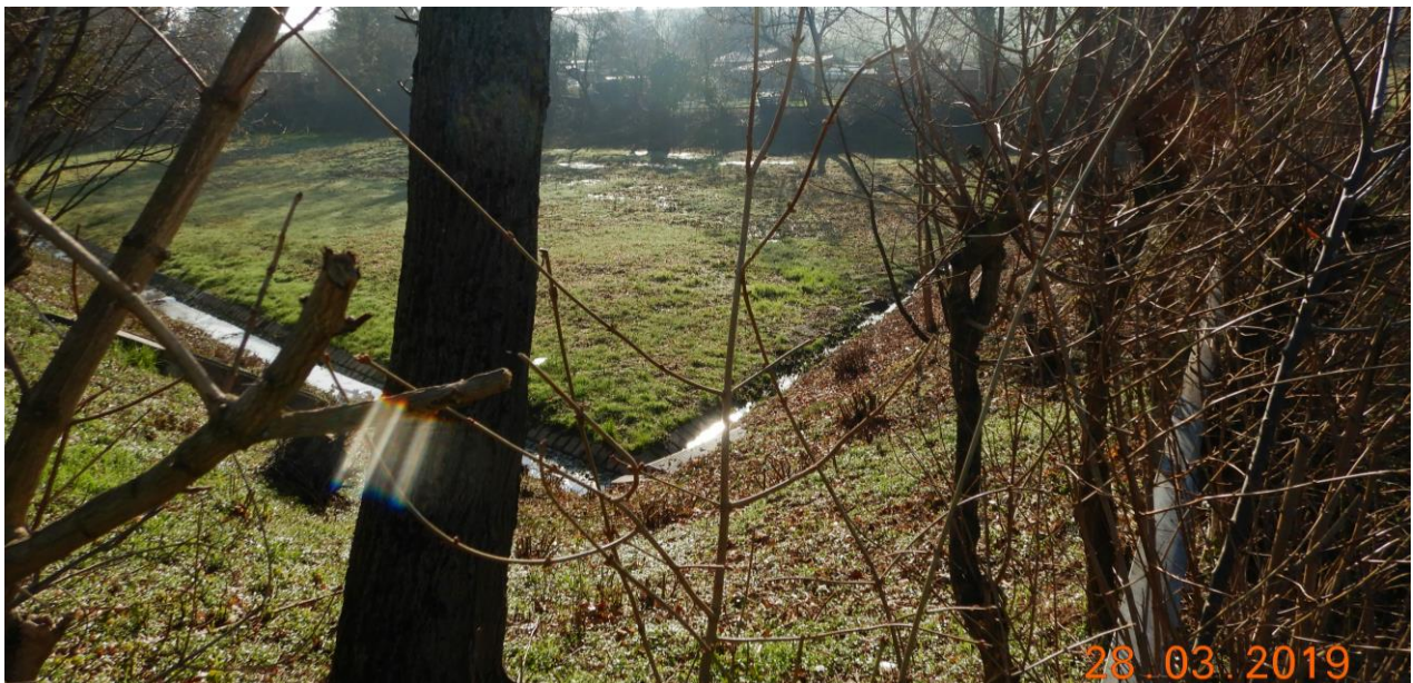
Abbildung 40: Regenrückhaltebecken am Riedbach, Göllheim
