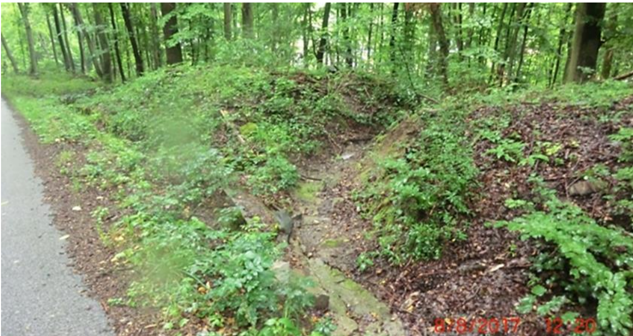
Abbildung 53: Beispiel einer wirksamen Wegewasserableitung.
