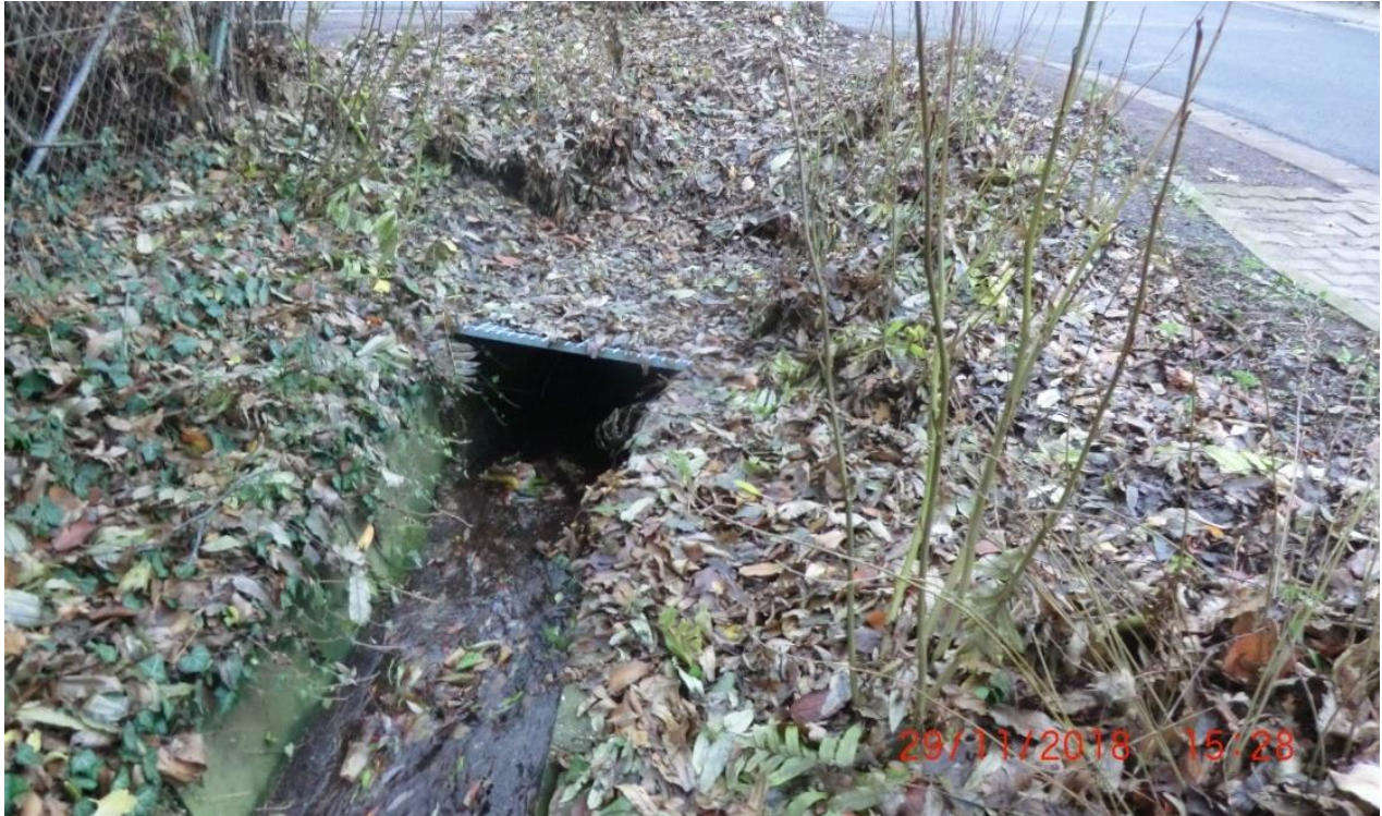
Abbildung 36: Einlassbauwerk in Gewässerverrohrungen, Einselfthum
