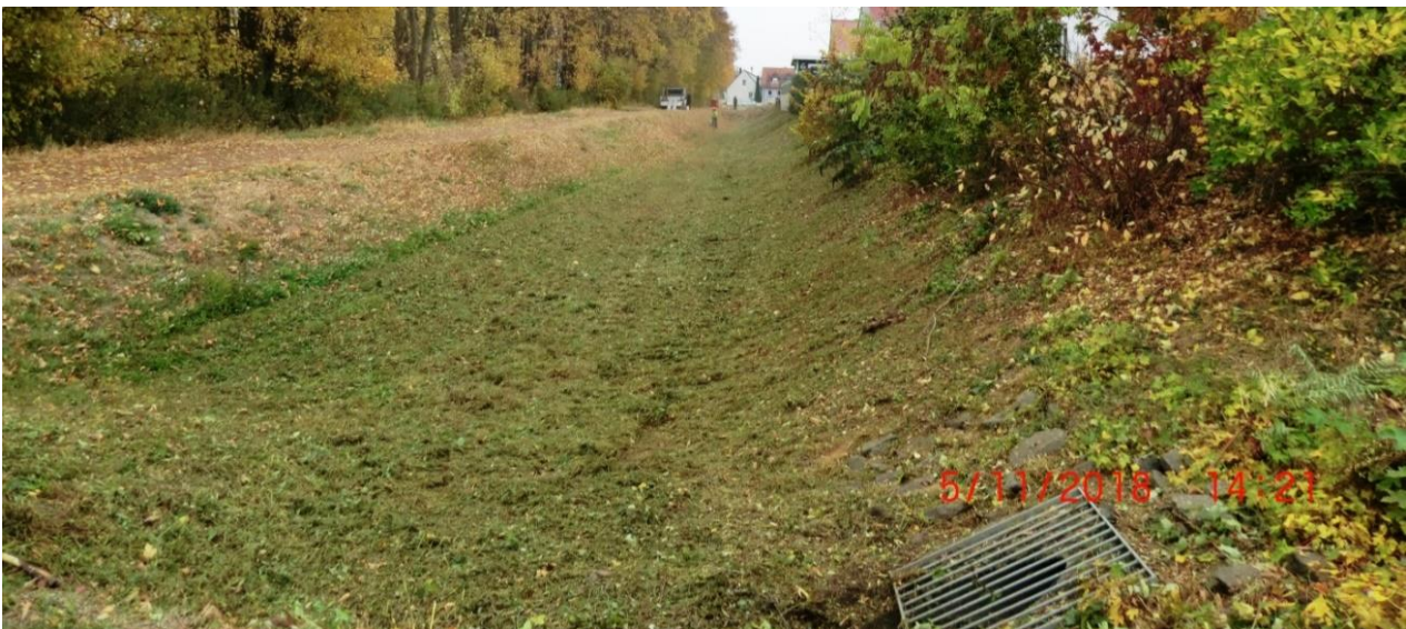
Abbildung 38: Rückhaltebecken NGB Süd III, Albisheim
