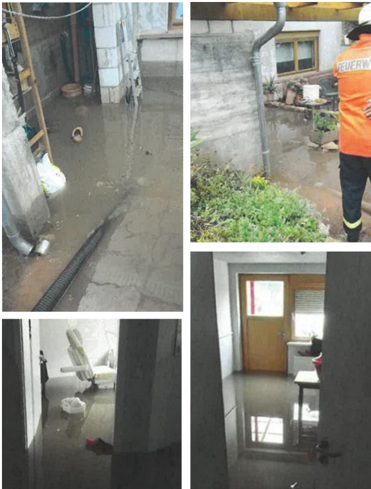
Abbildung 19: Dokumentierter Schaden in der Alleestraße in Albisheim
