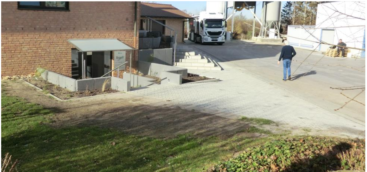
Abbildung 62: Überflutungsgefährdetes Gelände unterhalb einer Straße
