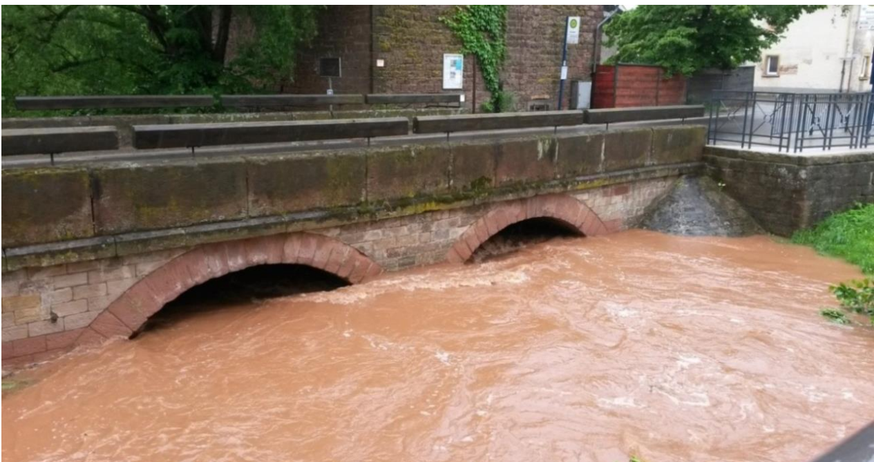
Pfrimmbrücke Bahnhofstraße, Mai 2016
