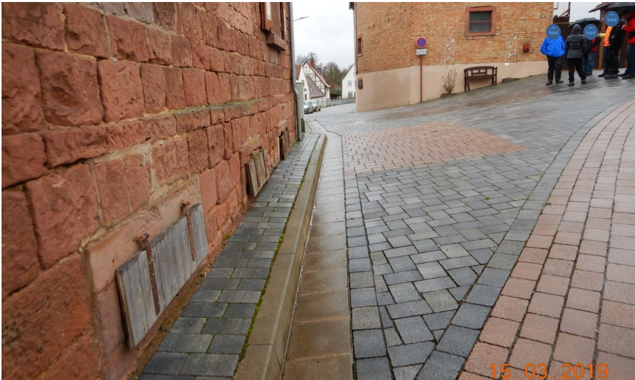
... auf die Mühlestraße trifft, werden überschwemmt und es kann zu Überflutungsschäden kommen. Örtl. Hochwasser- und Starkregenvorsorgekonzept Dreisen, Gefährdungsanalyse und Maßnahmen Juli 2021
