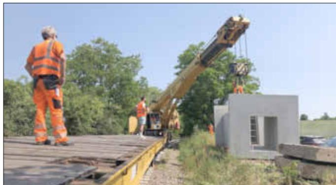
Arbeiten an der Zellertalbahn: Schienen-gestützter Kran mit Durchlass-Portal
