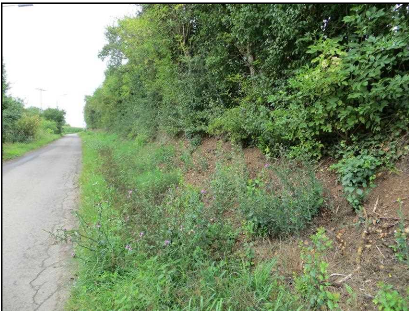
Abb. 2: Blick in Richtung S auf die Böschung entlang des Wirtschaftsweges
