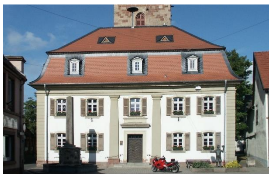
Mansarddach (Altes Rathaus)
