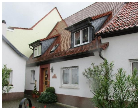
Beispiel für Dachgauben
