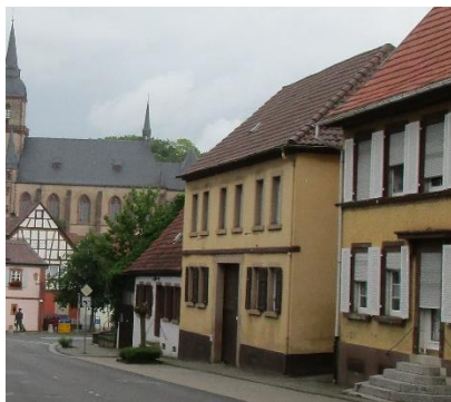
Walmdach in der Wormser Straße
