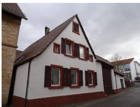
Die Klapppläden an den Fenstern ergeben ein durchgehendes Band (vgl. Abschnitt Klapppläden);
